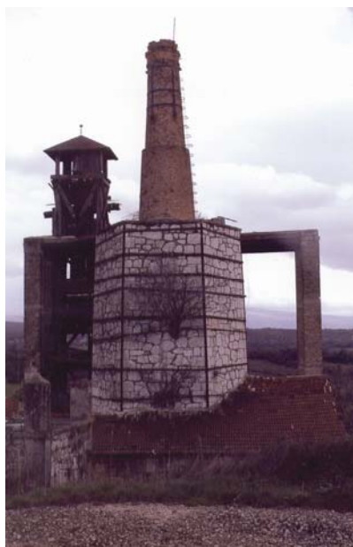
Napuštena vapnara u Tepljuhu pokraj Drniša
